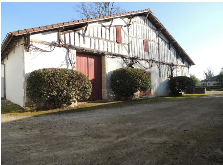
La partie Est de cette grange se trouve un local ne possédant pas de grenier, la hauteur sous toiture étant moins importante. La particularité de ce local, est qu'il possède en son milieu un pilier octogonal en pierre de taille de 2,5 m de hauteur environ. Ce pilier sert d'assise à une poutre maîtresse de la charpente
