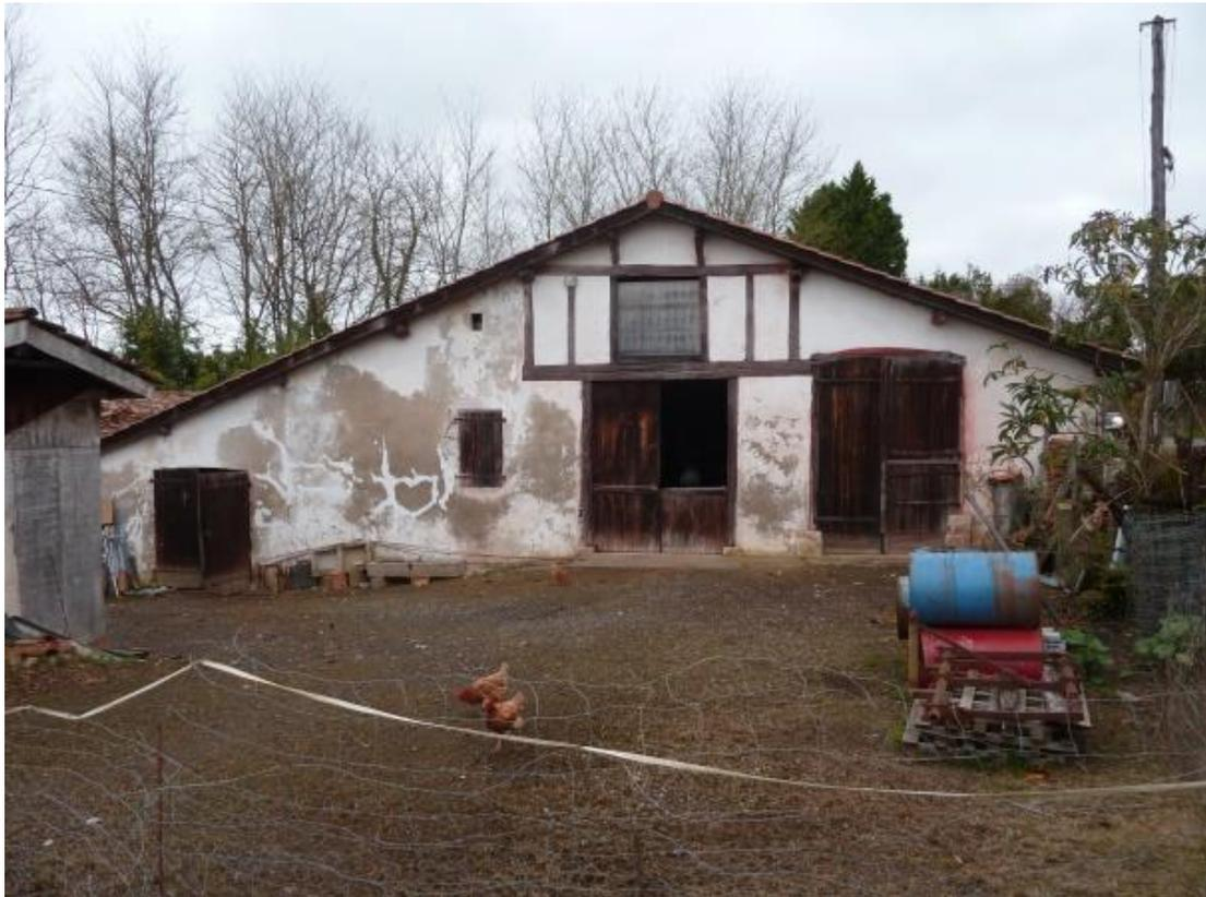
De gauche à droite : porte du chai, fenêtre de la partie habitation, porte du sol, porte de l'étable. Au-dessus du sol : fenil et séchage du maïs. La pente naturelle a été utilisée pour prolonger la toiture à l'ouest
