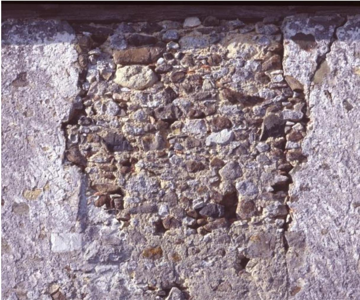
La zone de remplissage à gauche du mur peut aussi représenter une fenêtre à croisée qui a été démontée. Les empreintes des pierres des montants en incise dans le mur sont visibles.
