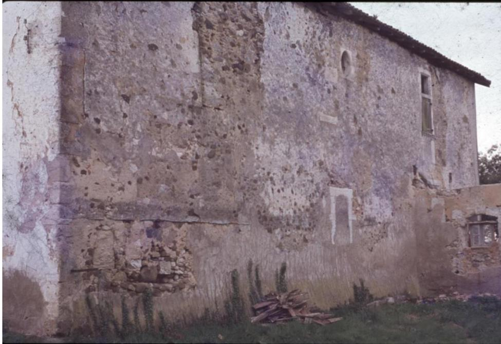
L'observation des pierres et du remplissage à droite de la fenêtre montre qu'il y avait autrefois une fenêtre à croisée. Le remplissage est aussi visible de l'intérieur.
