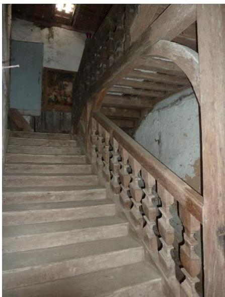
Escalier « de service » permettant d'accéder aisément aux greniers (1.2 m de largeur), en particulier au-dessus du sol (stockage du maïs sur un plancher à clairevoies facilitant le séchage).
