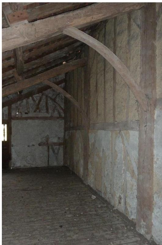
Grenier au-dessus du sol : Poteaux et aisseliers, mur de refend en torchis et au fond pignon avec remplissage de briques
